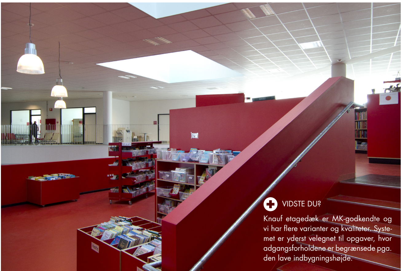
Nedhængt Knauf Danoline Systemloft. Fastgørelse i gipspladerne med Expanded Rosett.
