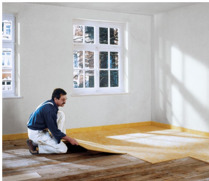
Bild 42: Mineralwolle-Dämmung
