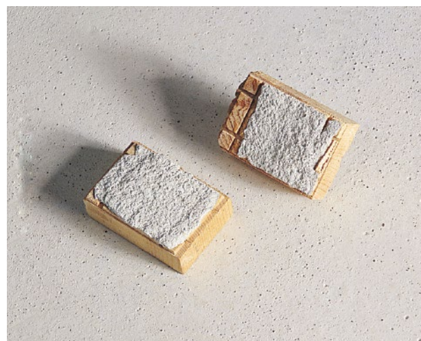
Bild 80: Parkett und Estrich-Bruchbild
