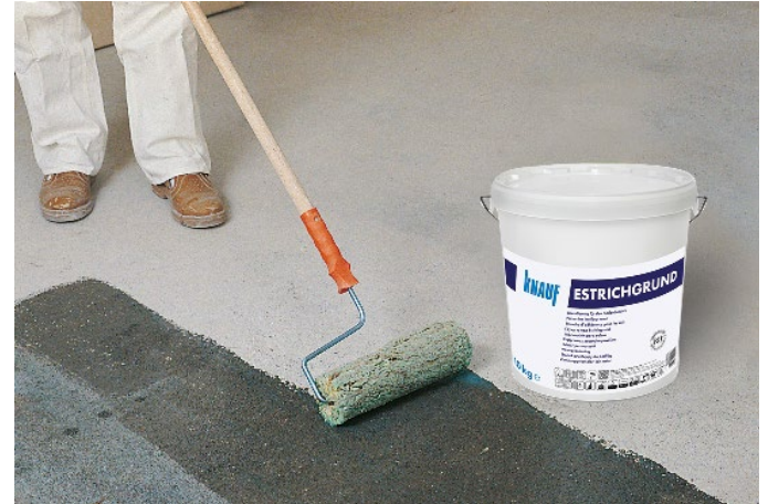
Bild 13: Estrichgrund auftragen
