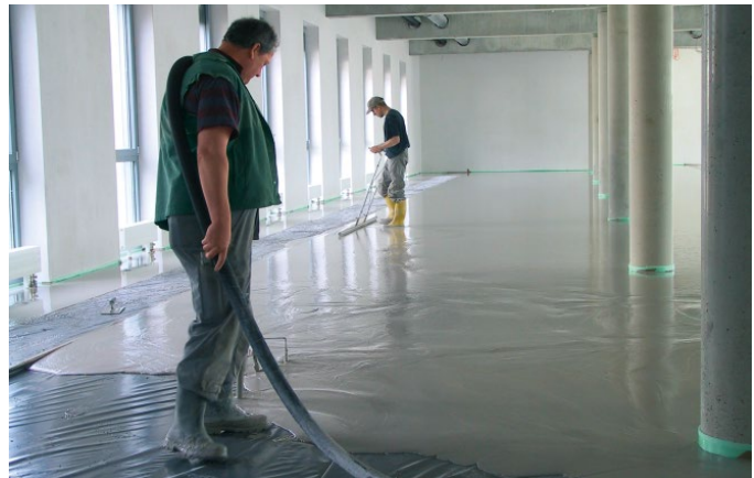
Bild 24: Einbau des Fließestrichs auf der vorbereiteten Hohlbodenkonstruktion
