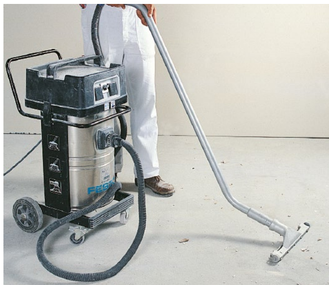
Bild 29: Reinigung mit Industriesauger
