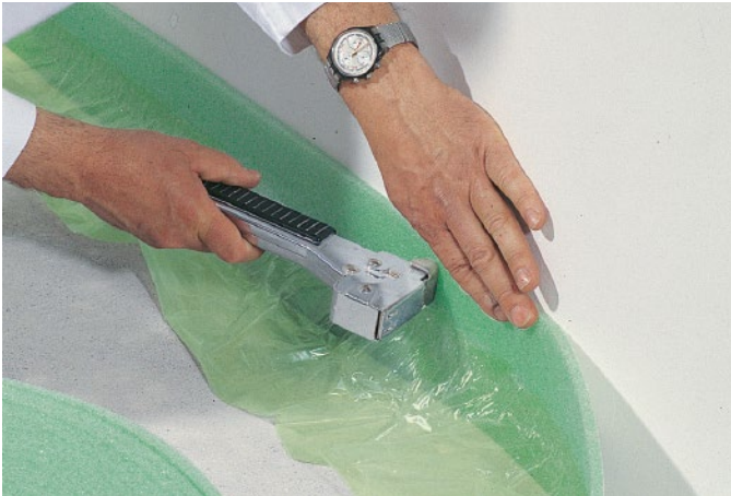
Bild 39: Randdämmstreifen mit Folie anbringen (auch an Rohren, Heizungsständern u. Ä.), nicht in Höhe des Estrichs klammern
