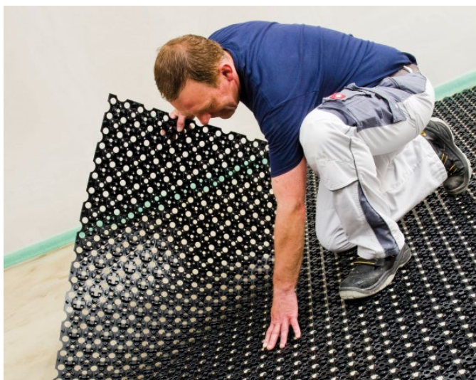
Bild 97: Aufkleben des Folienelementes auf den vorbereiteten Untergrund
