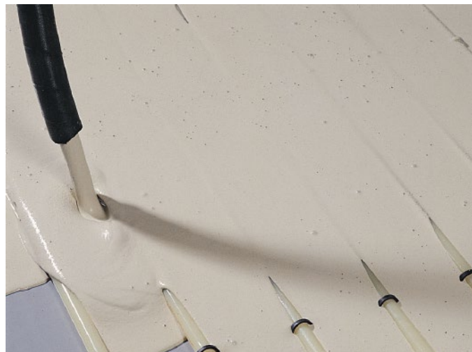
Bild 19: Heizestrich einbringen
