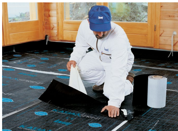
Bild 33: Abdichten von Kopfstößen mit Katja Sprint Anschlussstreifen
