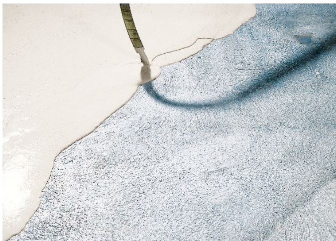
Bild 84: Maschineller Einbau N 410
