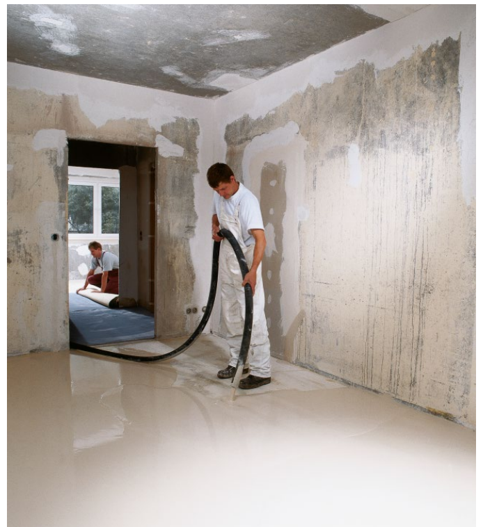
Bild 108: Z. B. maschineller Einbau N 440
