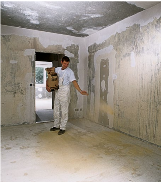
Bild 106: Z. B. Haftbrücke mit Quarzsandeinstreuung
