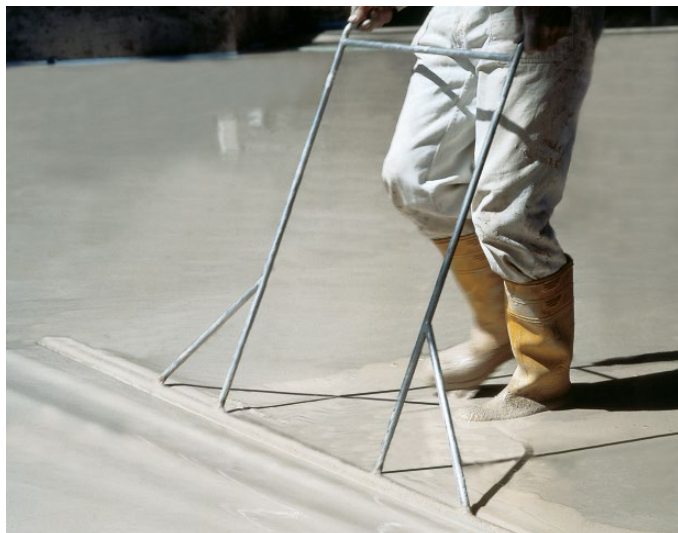
Bild 59: Bearbeiten mit der Schwabbelstange
