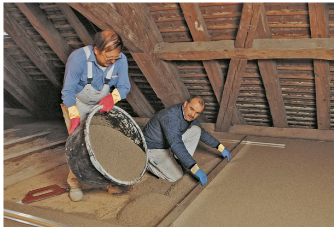
Bild 36: Ideal auf alten Holzbalkendecken: EPO-Leicht
