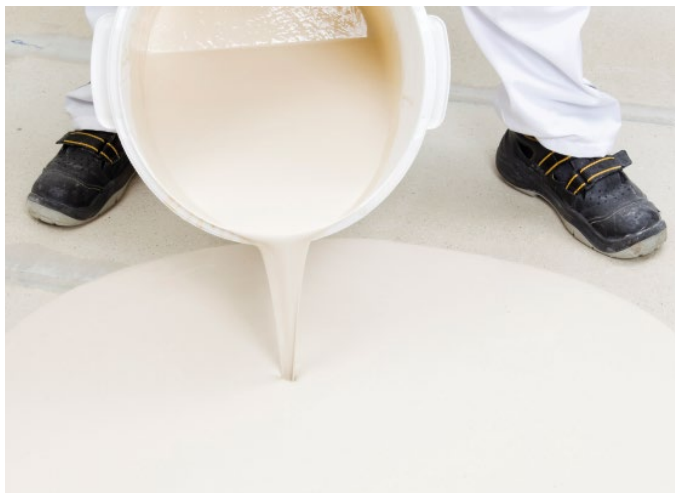
Bild 83: Einbau von Hand N 410
