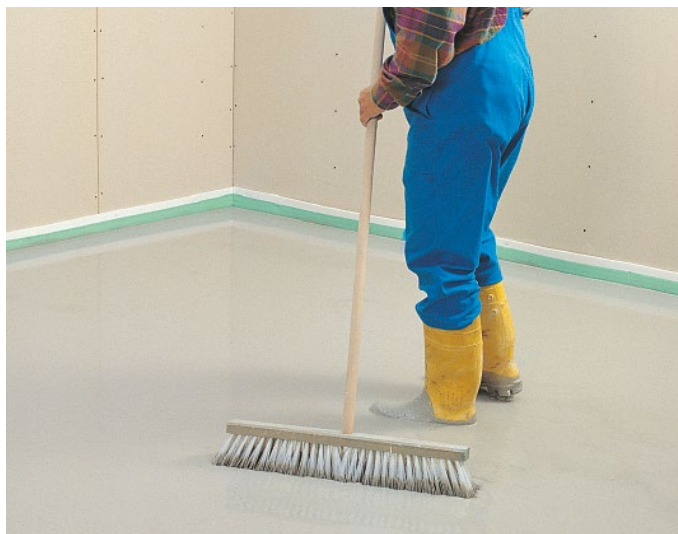
Bild 60: Bearbeiten mit Estrichbesen
