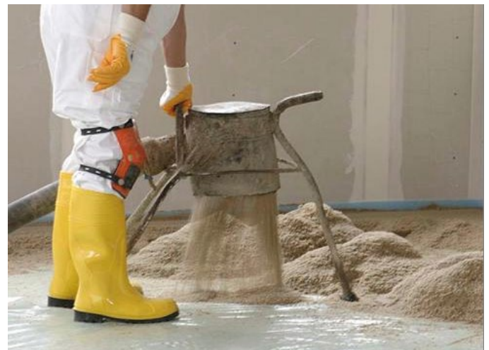
Bild 93: Einbringen mit Druckluftförderer
