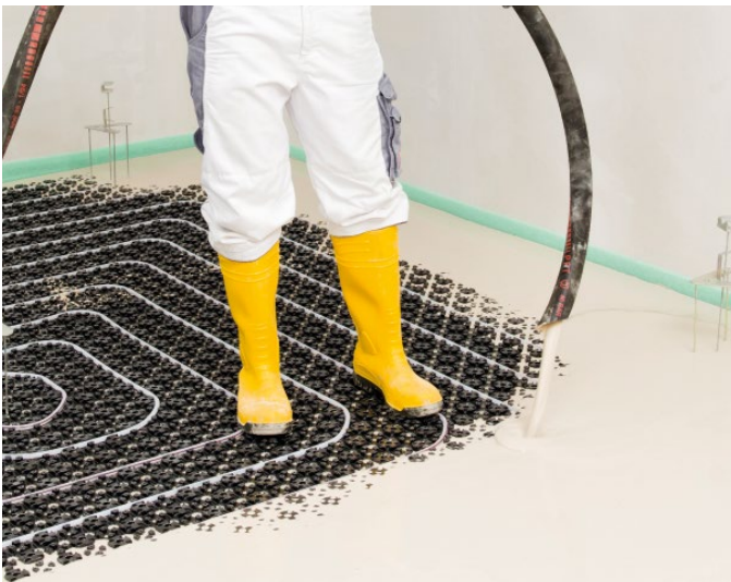
Bild 99: Vergießen des Mörtels N 440
