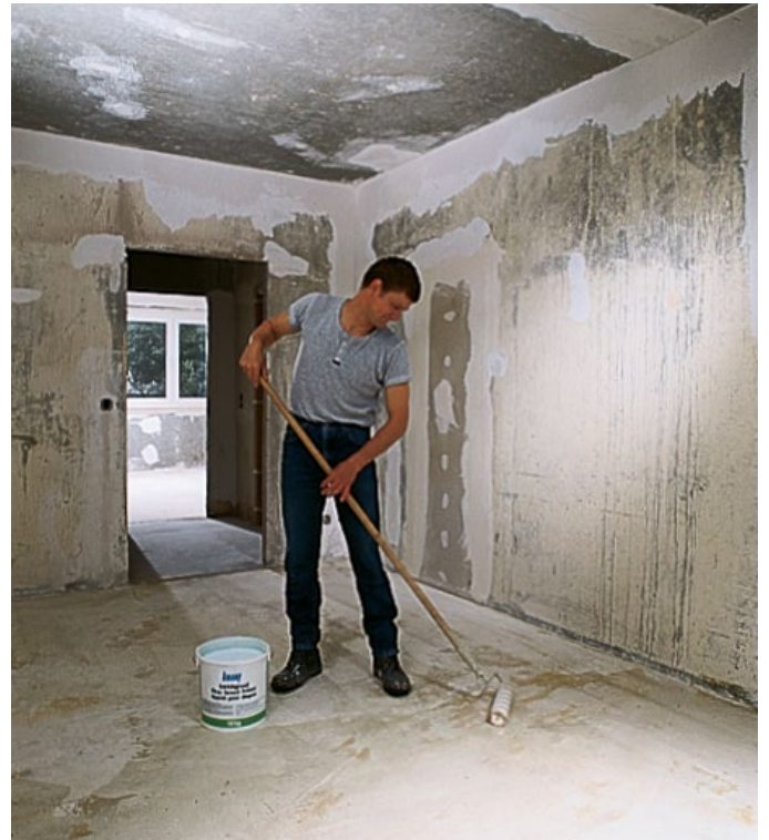
Bild 107: Z. B. Grundierung mit Estrichgrund
