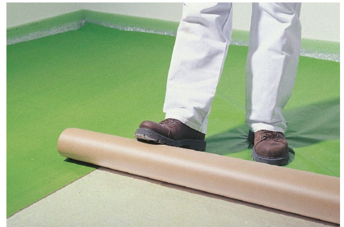
Bild 15: Trennschicht
