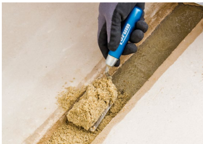
Bild 94: Ideal für schnelle Reparaturarbeiten: Stretto nach einem Tag belegreif
