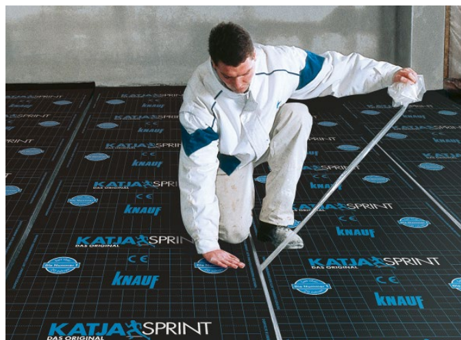
Bild 32: Schließen der Längsstöße durch Abziehen beider Folienstreifen
