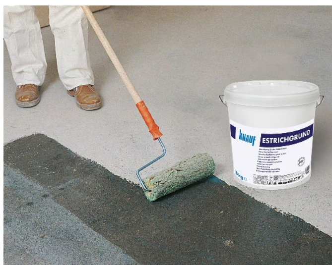
Bild 82: Auftragen von Estrichgrund
