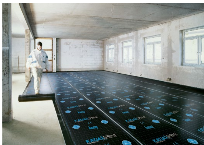
Bild 31: Katja Sprint Abdichtungsbahn: Schnell zu verlegen, hohe Ergiebigkeit
