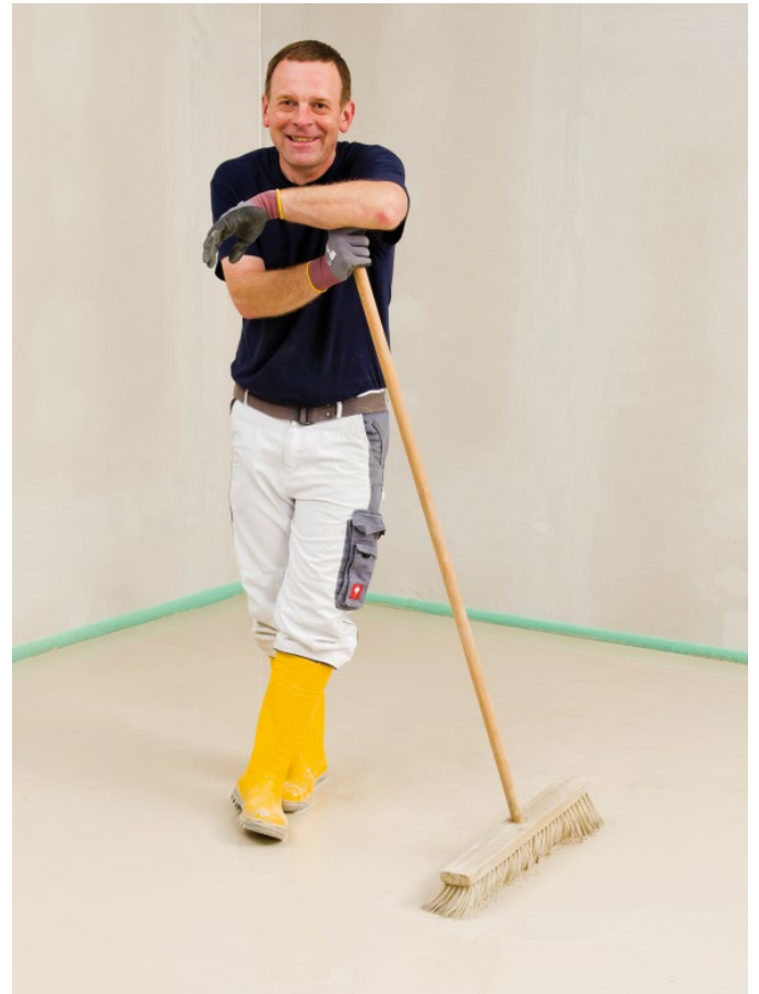
Bild 102: Bessere Oberflächen durch Bearbeiten mit dem Estrichbesen
