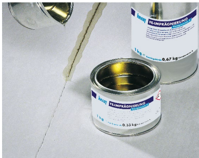
Bild 81: Verharzung von Rissen mit Epoxidharz
