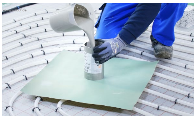
Bild 54: Konsistenzprüfdose mit Mörtel füllen
