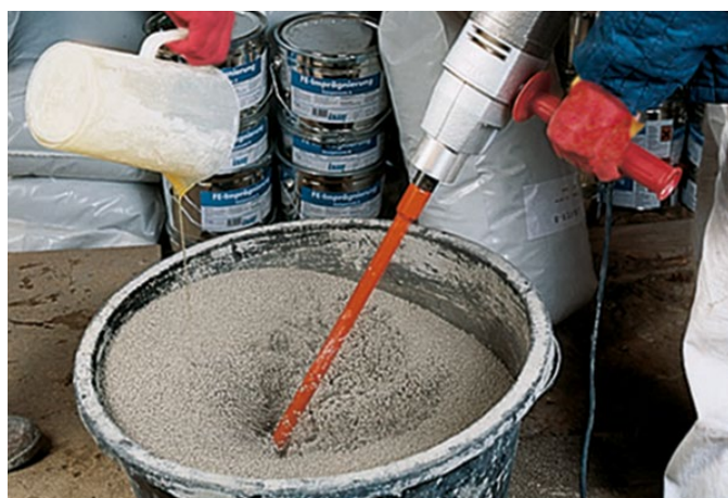
Bild 37: Das Mischen im Bottich erfolgt schnell und ohne großen Kraftaufwand
