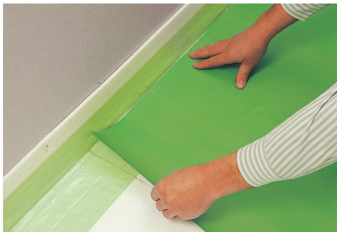
Bild 17: Auslegen von Knauf Schrenzlage
