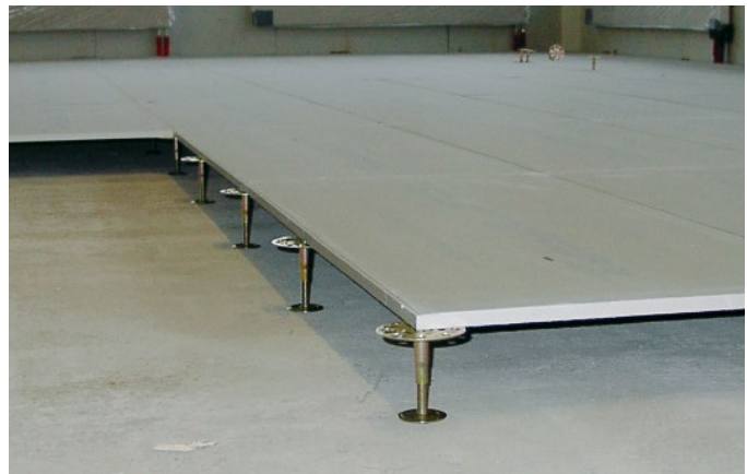
Bild 23: Verlegung von Stützen und Schalungselementen
