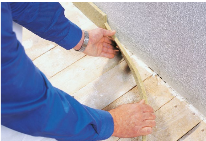
Bild 40: Verlegung Mineralwolle-Randdämmstreifen bei Anforderungen an den Brandschutz
