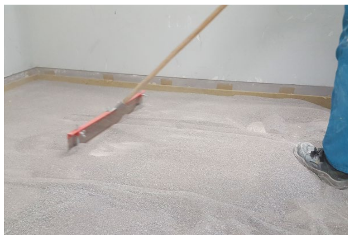
Bild 38: Einbau Schwere Schüttung
