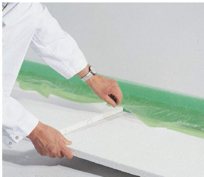
Bild 41: EPS-Dämmung
