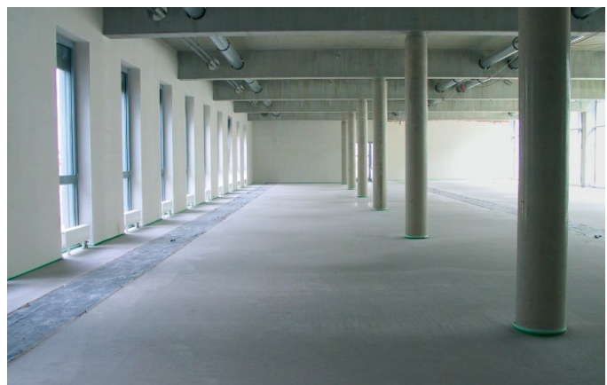
Bild 25: Fertige Estrichfläche als Hohlboden mit Doppelbodenkanal
