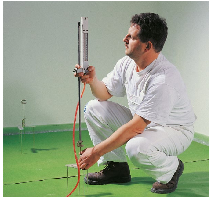
Bild 57: Einstellen der Höhe mit PFT Nivelliertaster
