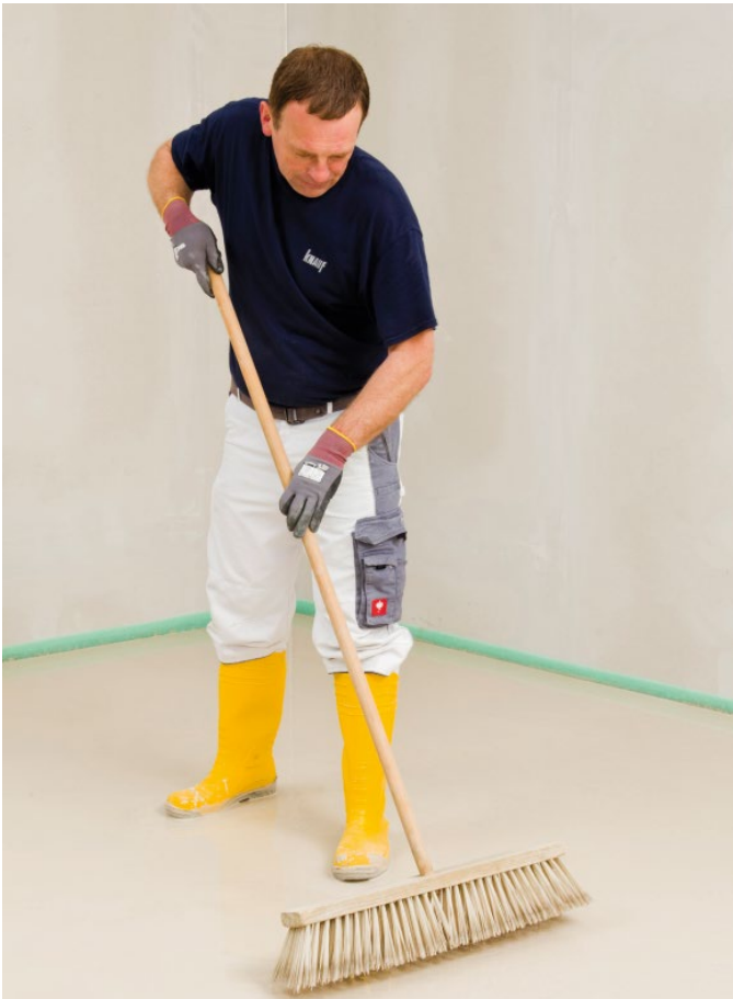
Bild 101: Durchschlagen mit einem Estrichbesen
